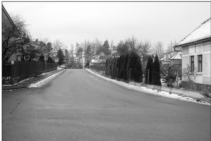
Chodníky v těchto místech zvýší bezpečnost chodců
